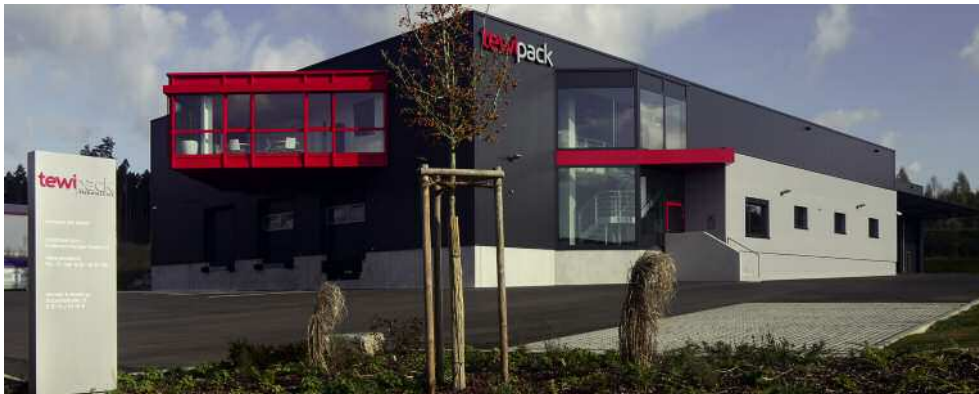
Das neue Logistikzentrum von tewipack hat 2000 Quadratmeter Nutzfläche.
