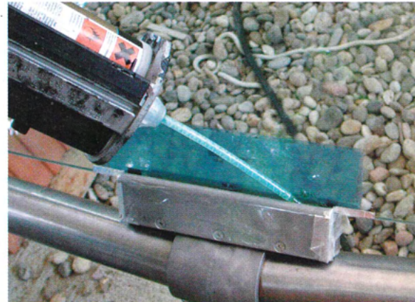
Die Verbindung zum Titanring wurde mit 3M Klebstoff auf Acrylbasis hergestellt. Als Abstandhalter dienten 3M Bumpon Elastikpuffer.
