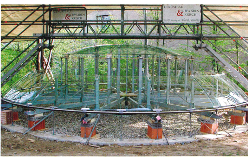
Ein Foto aus der Bauphase: Die oberen und unteren Scheiben sind bereits aufgelegt.
