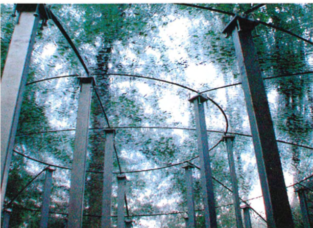
Während der dreiwöchigen Aushärtungszeit des Klebers hielten die Stützen die Kuppel stabil.
