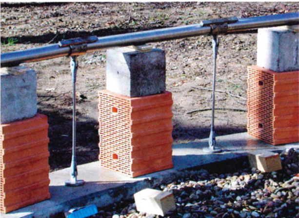
Über Verbindungselemente wurde ein Titanring mit den Aufnahmeelementen für das Glas positioniert.
