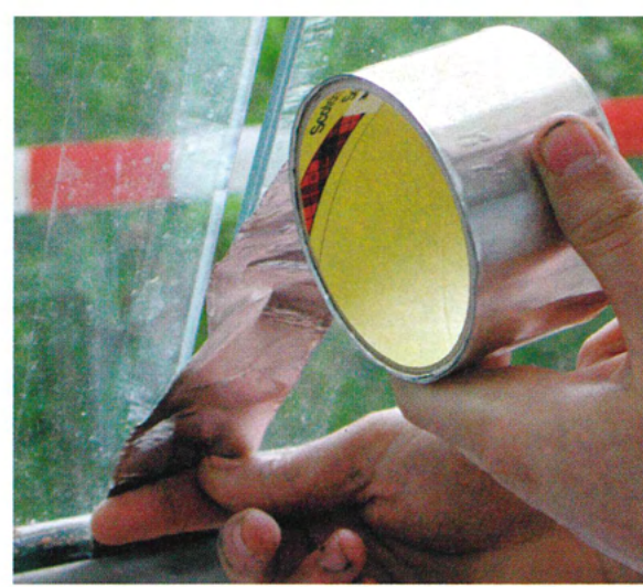
Vor dem Verkleben wurden die Unterseiten der Fugen mit 3M Weichaluminiumband verschlossen.
