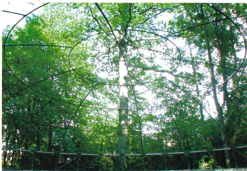
Größtmögliche Transparenz: Die 44 Glaselemente aus 8 mm Float und 2 mm chemisch vorgespannten Glas sind insgesamt 1,5 Tonnen schwer und lediglich mit Klebstoff verbunden. Getragen wird das Gewicht von der 8 mm starken Scheibe.
