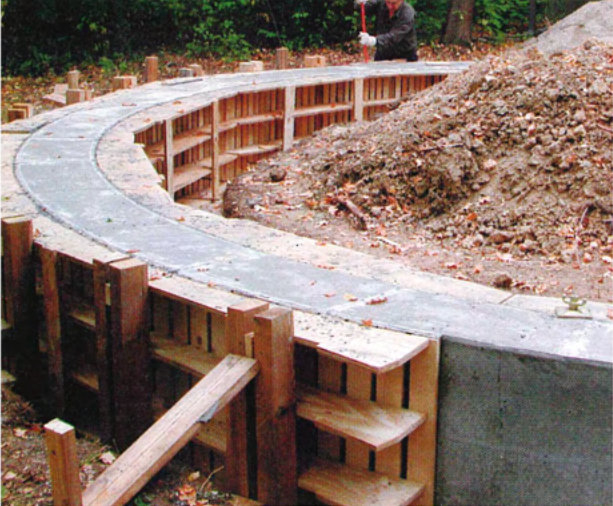
Als Fundament musste zunächst ein Betonring gegossen werden.
