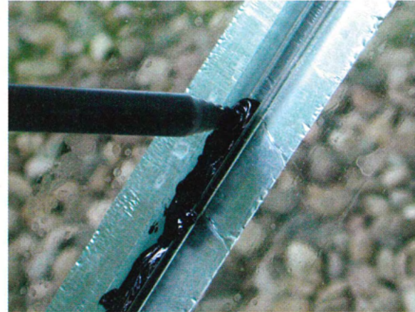
36 Kilogramm des thixotropen Klebstoffs von 3M wurden verarbeitet.
