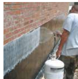
Für eine schnelle, einfache Schaumstoffplatteninstallation sprühen und kleben Sie einfach mit 3M™ HoldFast 70 Sprühklebstoff in Flaschen. Verklebt Schaum auf Beton, Abdichtungen, OSB und mehr, ohne den Schaum zu beschädigen.
